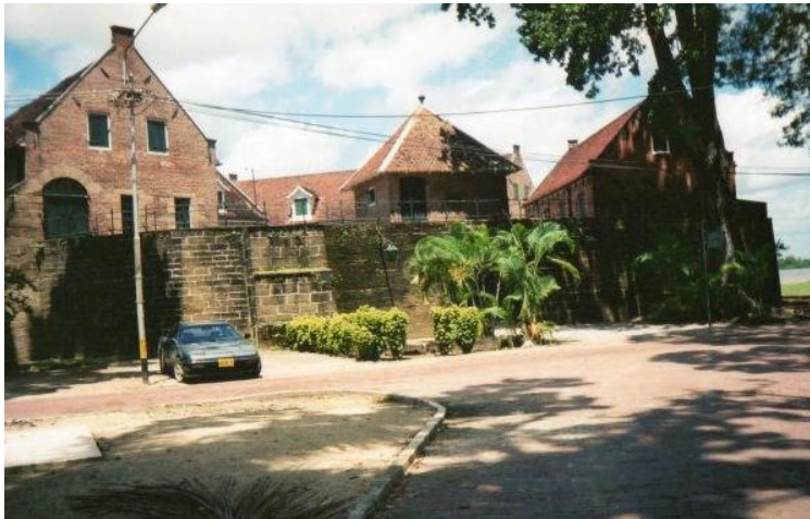
Het fort Zeelandia
